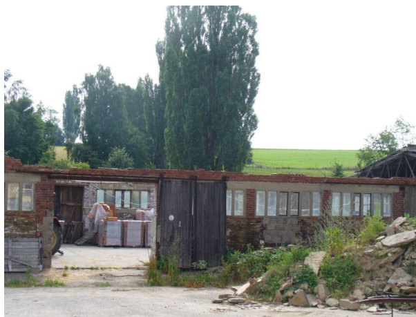
Abbildung 13: Halsbrücke, Nähe Kanzleilehngut
